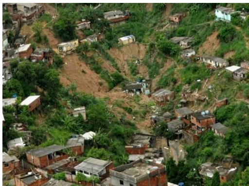
Foto A.1: Deslizamento de encosta no Morro do Bumba, em Niterói, em abril de 2010. (Disponível em: http://veja.abril.com.br . Acesso em 04 de setembro de 2011).
